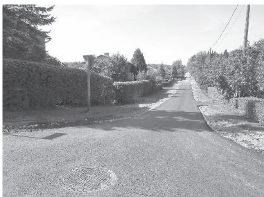
Pēc ūdenssaimniecības darbu pabeigšanas Jāņkalna iela ieguvusi jaunu asfalta segumu
