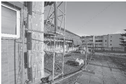
Turpinās ēkas siltināšanas darbi projektam „Kompleksi risinājumi siltumnīcefekta gāzu emisiju samazināšanai Jāņmuižas pirmsskolas izglītības iestādē, Priekuļu novadā” Nr.KPFI – 15.3/21.
